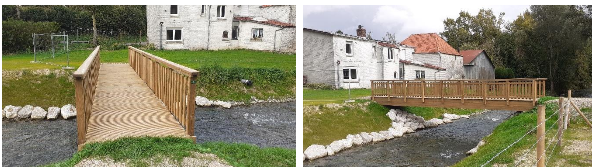
Exemple de mise en œuvre d'une passerelle en bois par PCM-INGENIERIE
