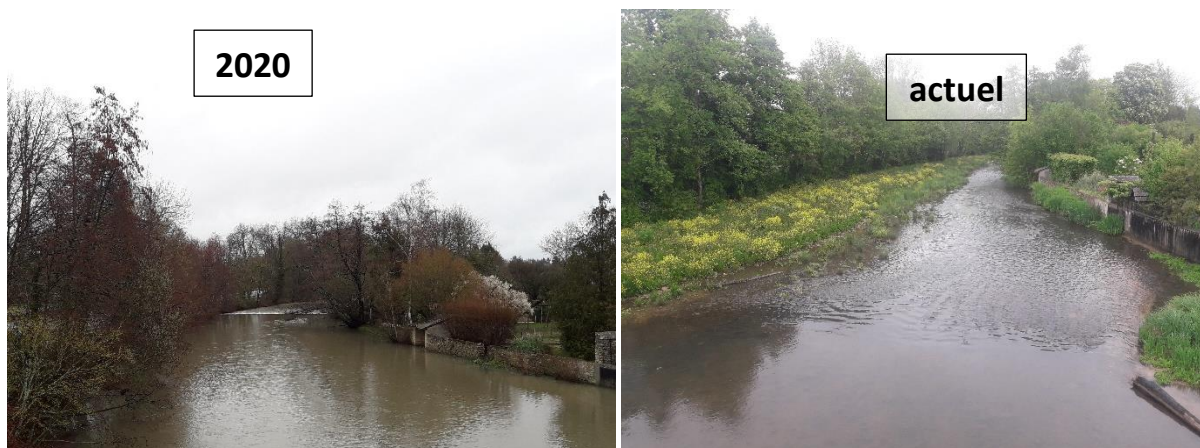
Mise en œuvre de banquette sur le Loing à Montbouy dans le Loiret (45). © PCM-INGENIERIE
