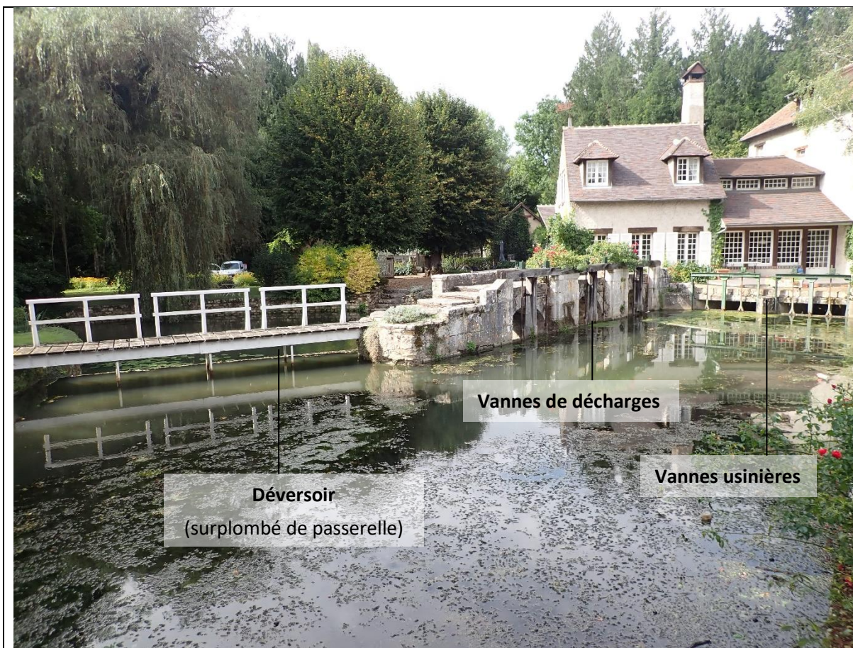
Dispositifs du moulin de la Fosse
